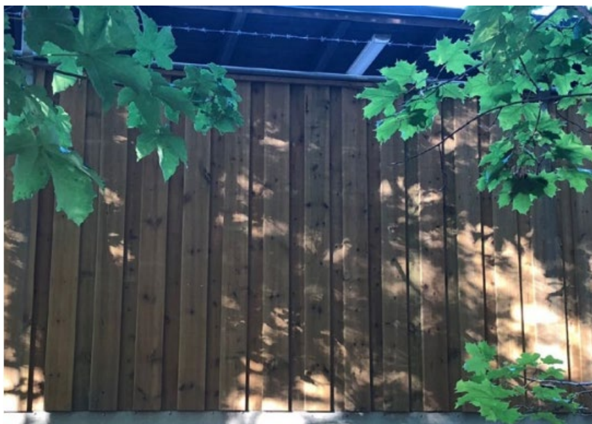
Bild 2. Integrerat bullerplank med taggtråd för att försvåra klättring. Källa: SKR (2019:62), Sebastian Ihre (WSP).
