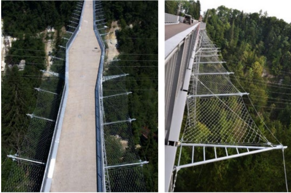
Bild 3. Stålnätsapplikation vid Hagen i Schweiz. Källa: SKR (2019:66) & www.mma-architectural.co.uk
